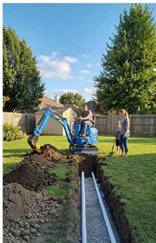
DIG DRAINAGE DITCHES
