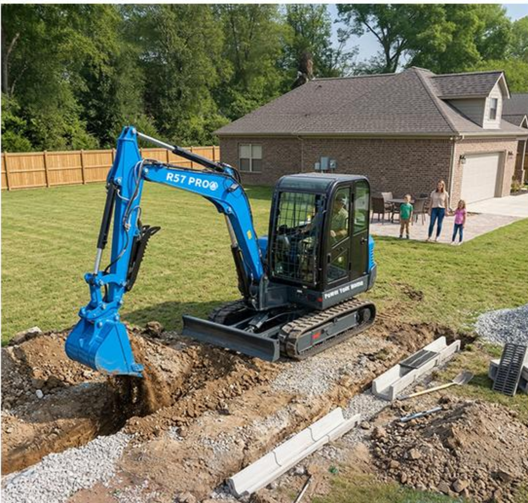
DIG DRAINAGE DITCHES
