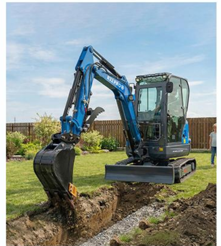
DIG DRAINAGE DITCHES
