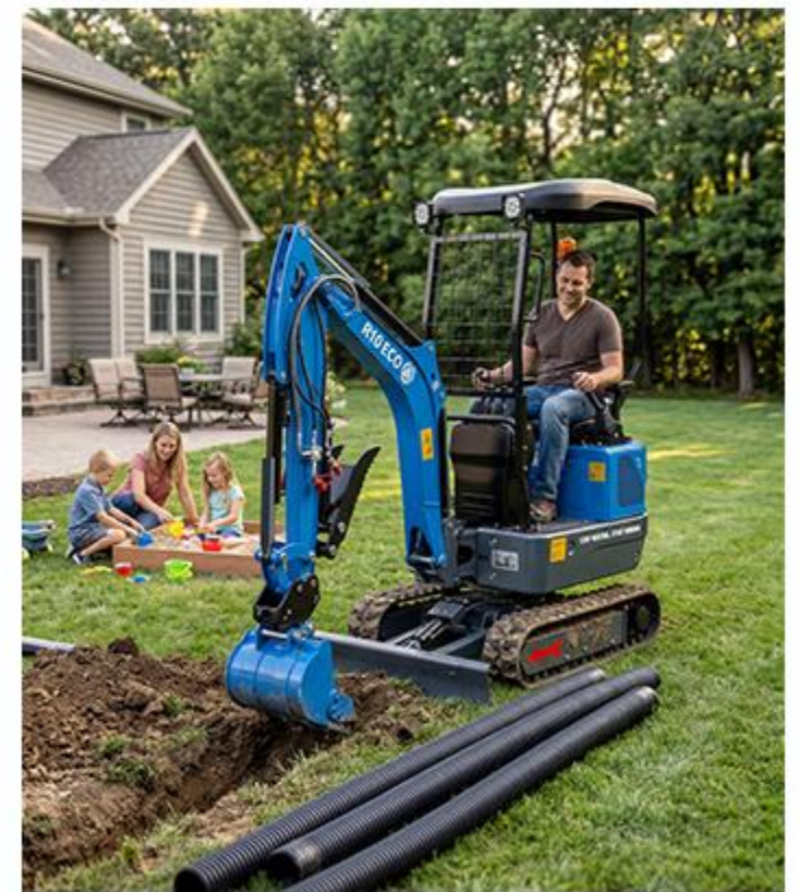
DIG DRAINAGE DITCHES
